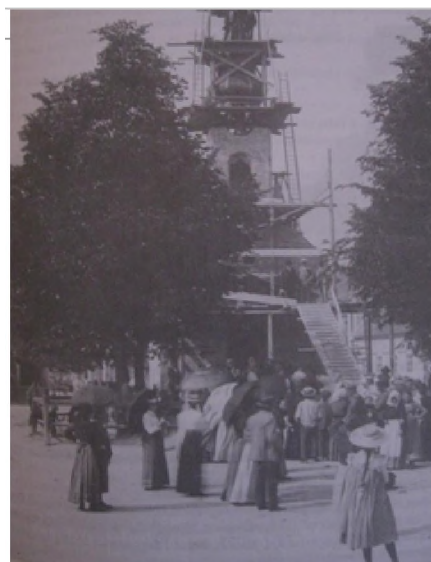
A Rozália kápolna átépítése
