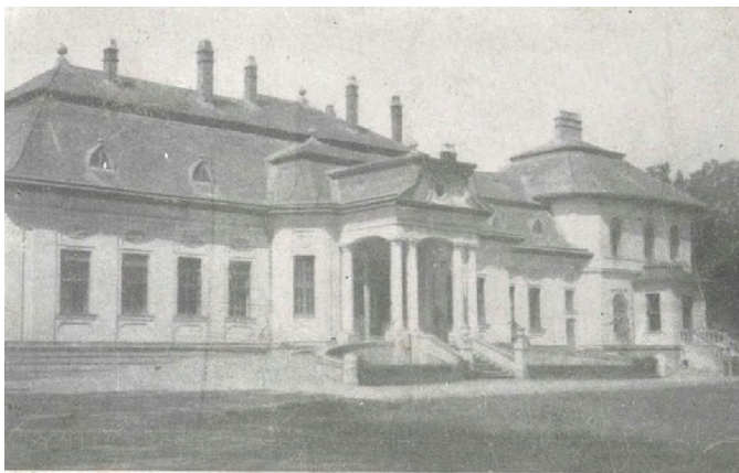
A GYŐRI VASASOK NOVÁKPUSZTÁN A GYŐRI MEGYEI ÖRÖKÖS ISKOLÁJÁNAK ELŐZŐ ÉPÜLMENYE
