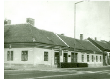
Az egykori nyomda épülete
