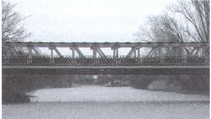
Ideiglenes keskeny vashíd 1992-2009 között
