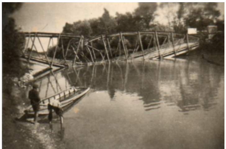
A II. világháború végén felrobbantott híd
